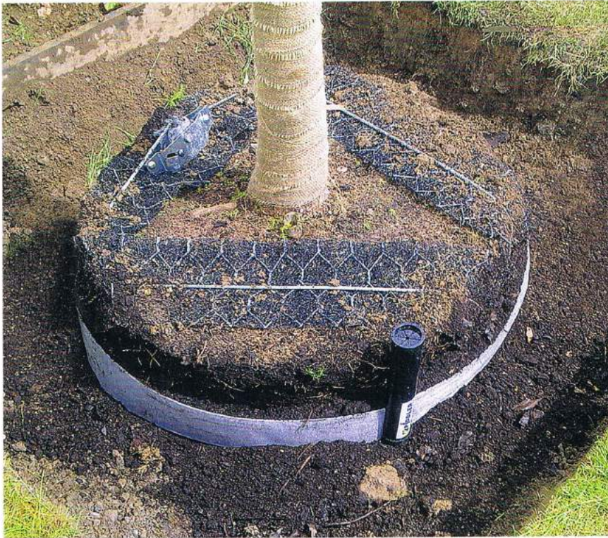
Über den Bewässerungsstutzen wird das Wasser durch die Membran direkt zum Wurzelballen geführt. Foto: Platipus
